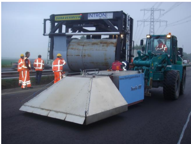
Opwarmen en drogen van ondergrond bij project Rollpave van Dura Vermeer
